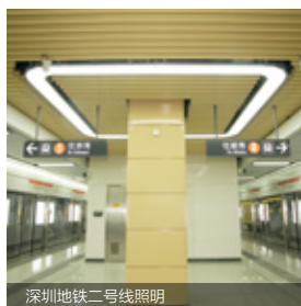
深圳地铁二号线照明
